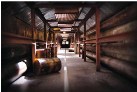
4-5 Kontrollzentrum (© Sebastian Gille 2013, TU Kaiserslautern)
